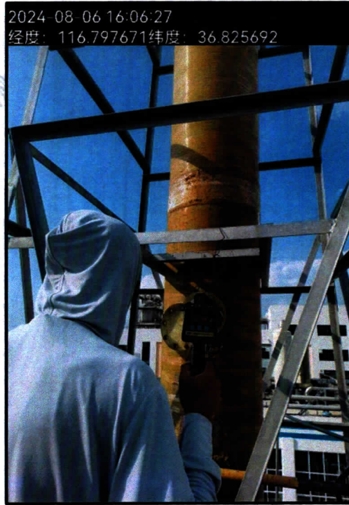
附图 5: DA001 废气排气筒处理设施后废气采样
